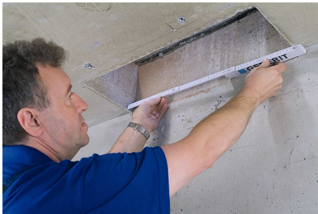
Bild 5 Ausmessen der Deckenöffnung
