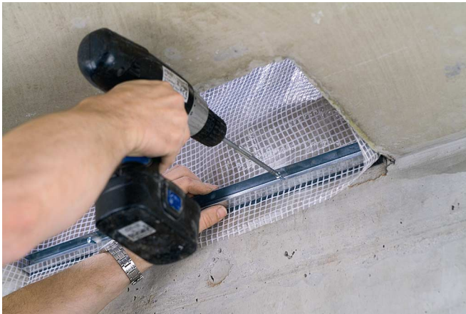
Bild 7 Schienen und Spezialfolie montieren.
