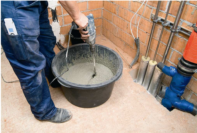
Bild 11 Die Vergussmasse anrühren
